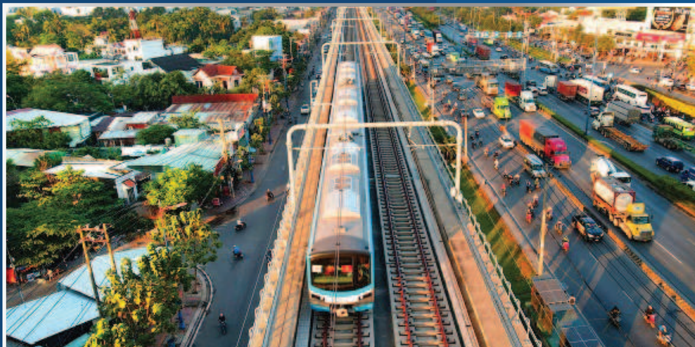
Dự án: Metro số 2 Hồ Chí Minh. Địa điểm: Thành phố Hồ Chí Minh. Hạng mục: Tư vấn giải pháp đấu nối và cung cấp vật tư phụ kiện hàn điện trở trên toàn tuyến.
