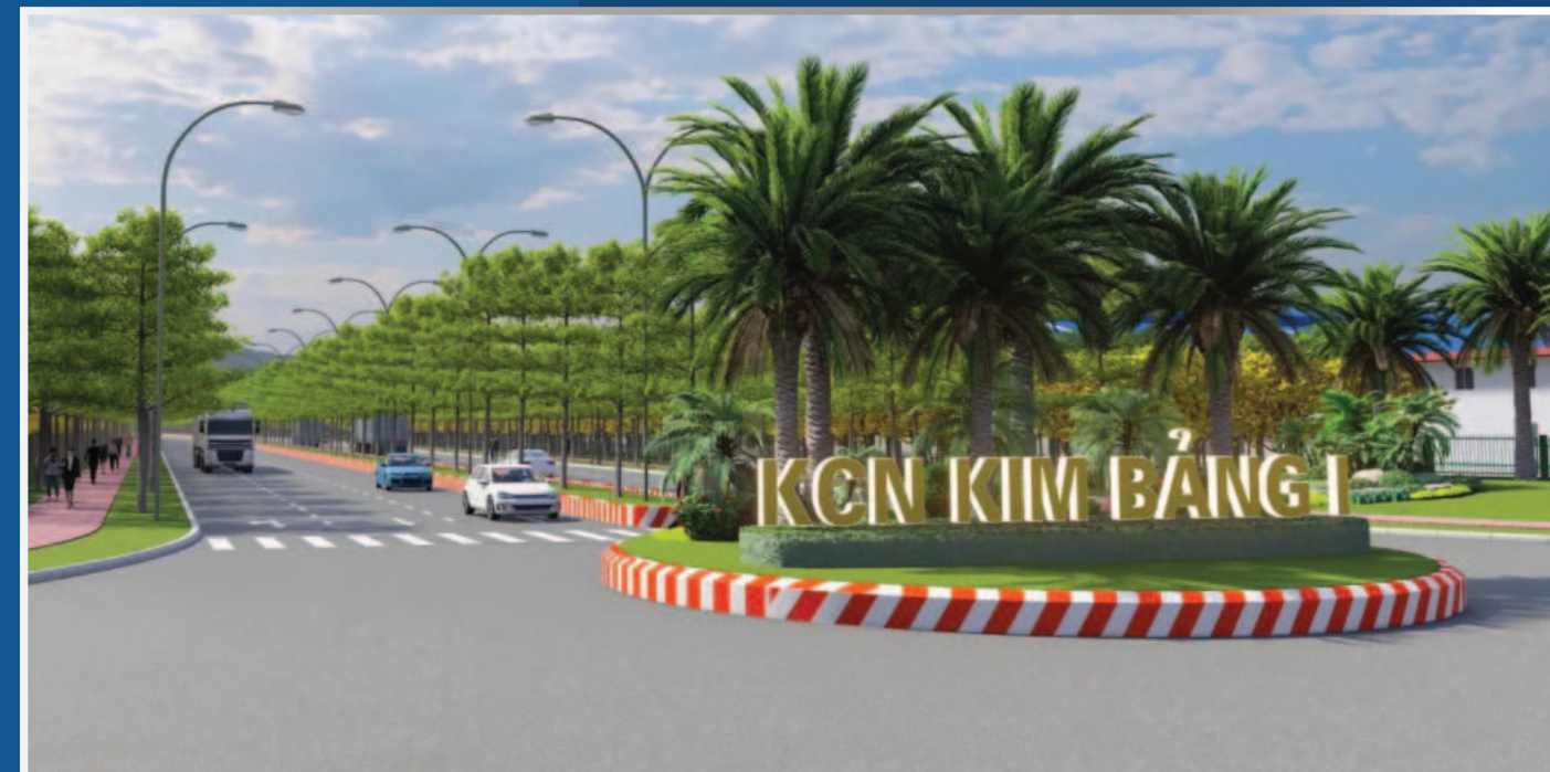
Dự án: Khu công nghiệp Kim Bảng I. Địa điểm: Phường Đại Cường, Đồng Hóa và Lê Hồ, TX Kim Bảng, Hà Nam. Hạng mục: Hạ tầng KCN, hệ thống chữa cháy ngoài nhà.
